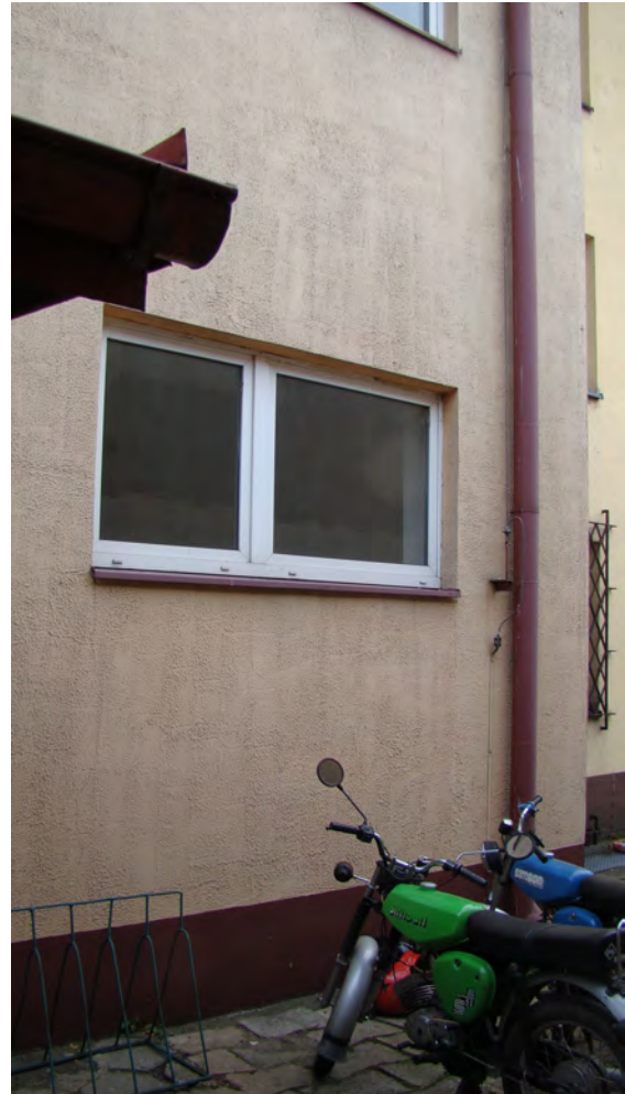
Widok ogólny miejsca, w którym zlokalizowane zostaną drzwi. Szerokość drzwi równa będzie szerokości istniejącego okna.
