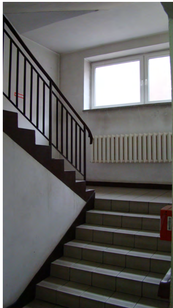
Widok klatki schodowej od środka, rozkucie otworu okiennego wykonane zostanie do poziomu posadzki.
