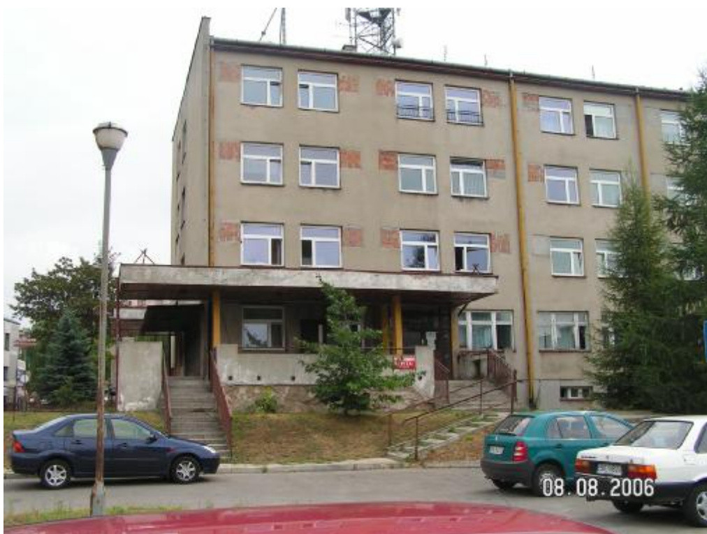
Fot. 1. Budynek pawilonu łóżkowego
