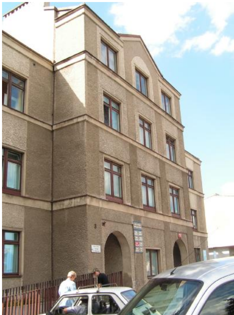
Fot. 5. Elewacja frontowa budynku Przychodni Specjalistycznej
