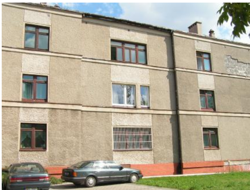
Fot. 6. Elewacja tylna budynku Przychodni Specjalistycznej
